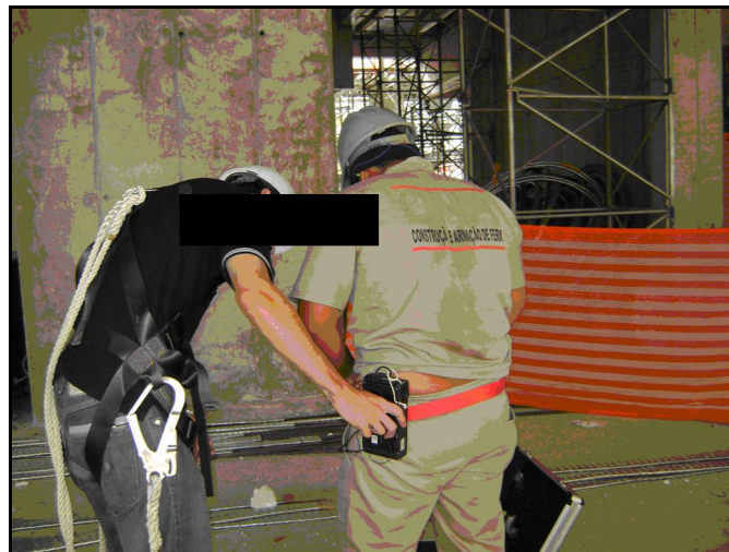
Figura 04 – Instalação dos dosímetros (carpinteiros e armadores)
