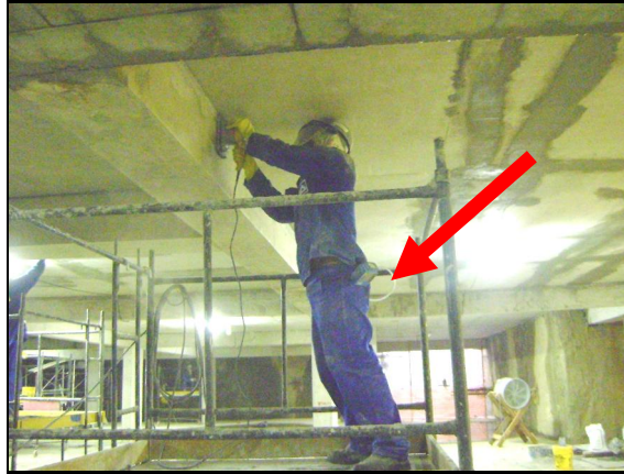
Figura 11 – Atividade de lixamento de concreto (2º Subsolo), detalhe do equipamento de amostragem instalado no trabalhador
