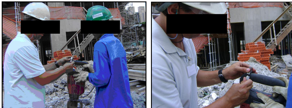
Figura 07 e 08 – Instalação do acelerômetro no martelete
