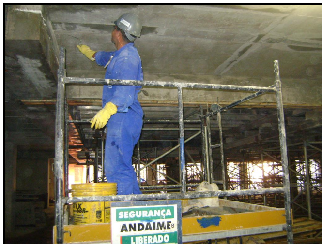
Figura 10 – Pedreiro realizando aplicação de argamassa (3º Subsolo)
