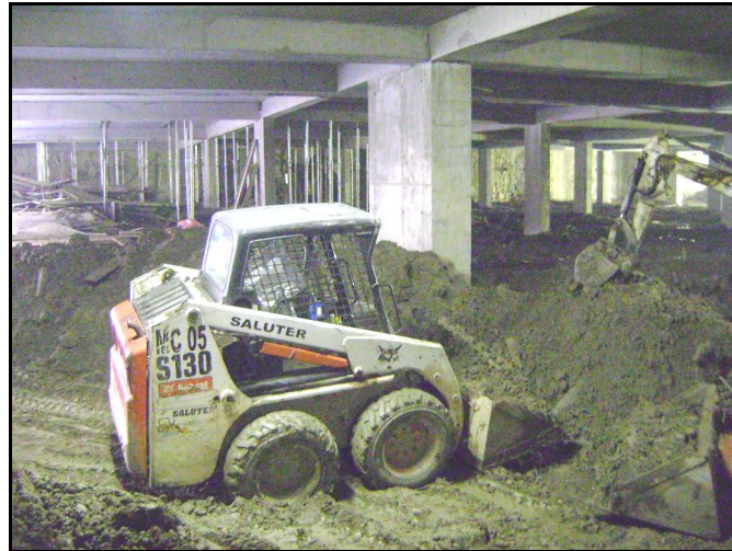
Figura 15 – Movimentação de terra em área parcialmente fechada
