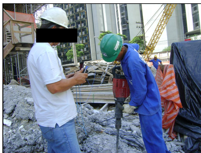
Figura 09 – Utilização do martelete com o acelerômetro acoplado
